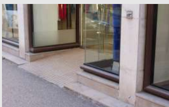
porte en retrait - pente anti dérapante
