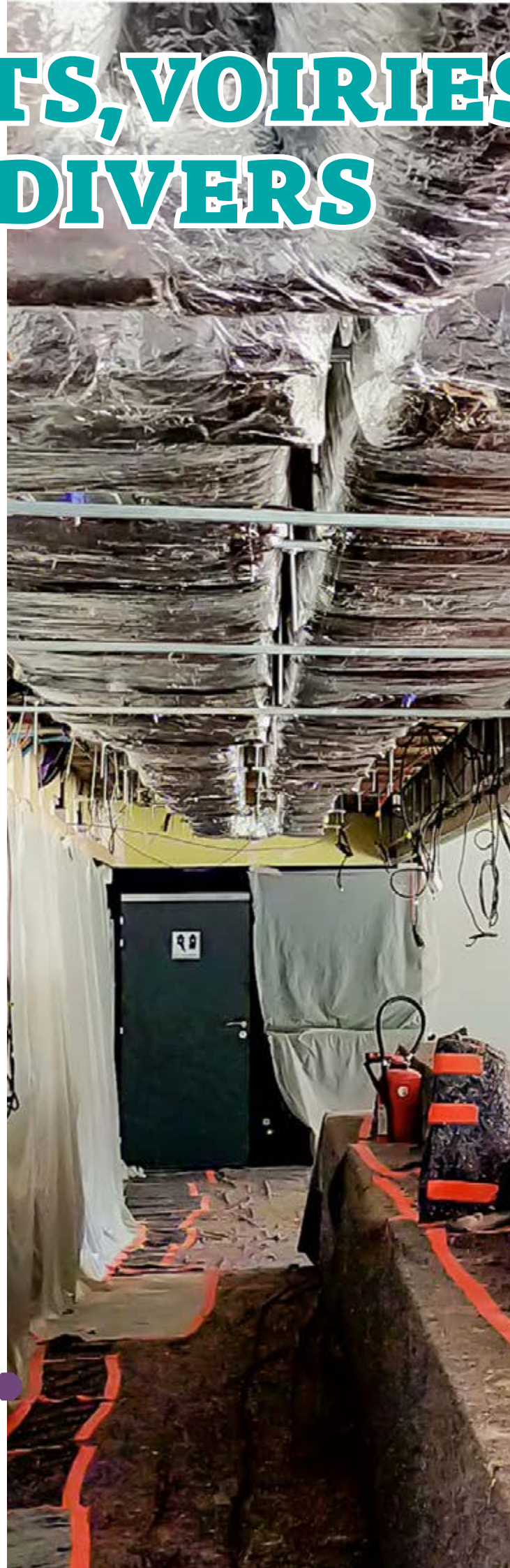
Travaux au Gueulard Plus de Nilvange
