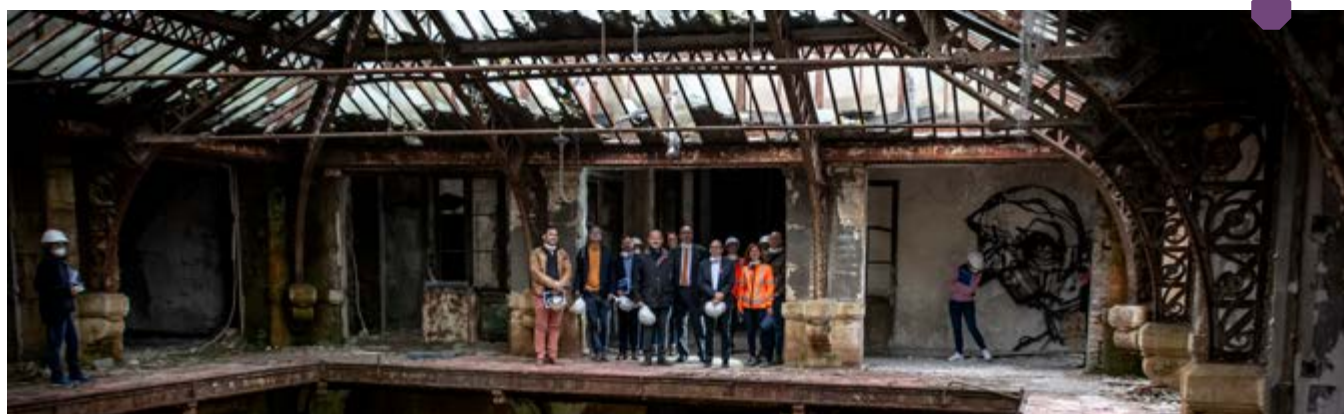
Les grands bureaux de Hayange
