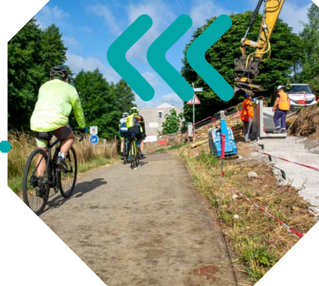
Création d'une rampe d'accès à Ranguevaux
