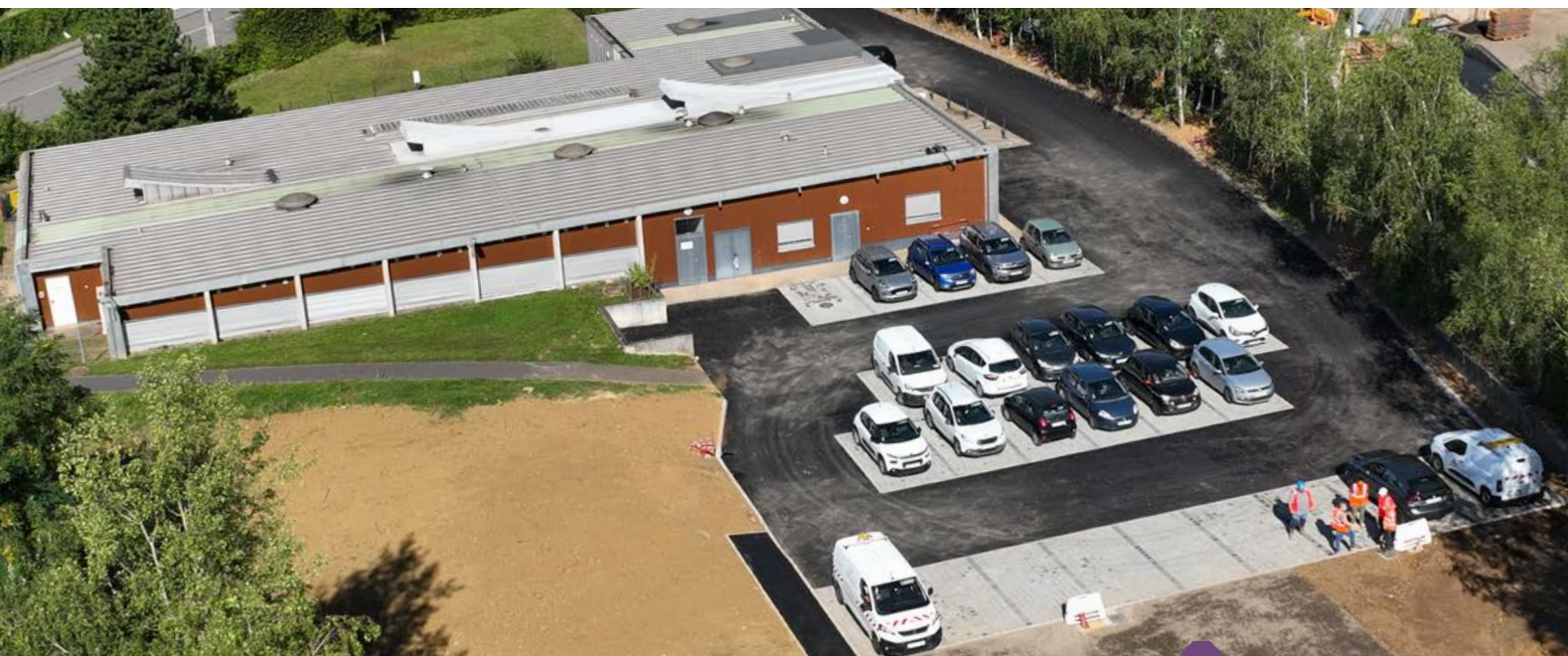
Travaux d'extension du parking de la crèche La maison des doudous à Hayange
