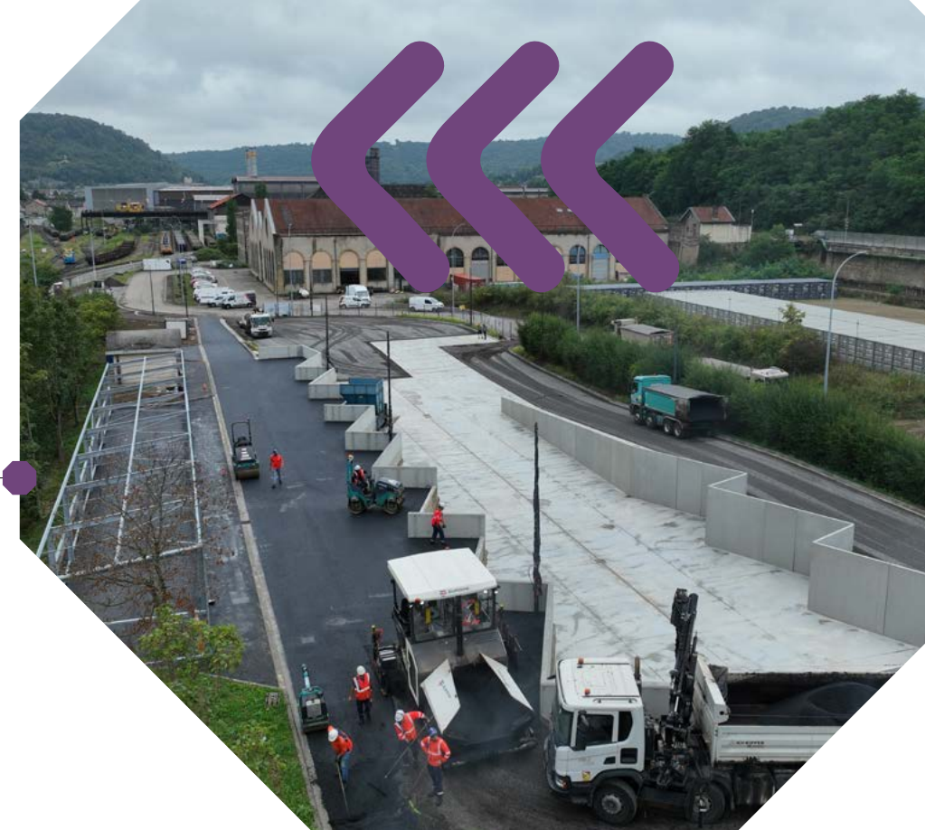
Requalification de la déchèterie de Hayange
