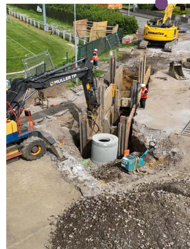
Travaux d'assainissement sur la rue du Stade à Nilvange
